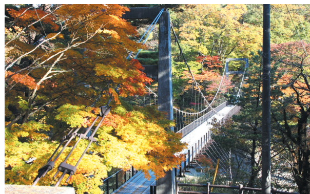
荒川峡もみじライン（鷹の巣吊橋）
