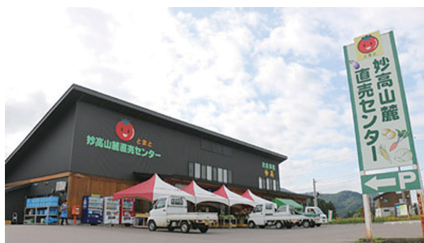
国道18号沿い坂口新田にある妙高山麓直売センターとま
