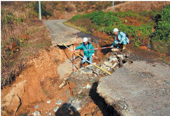
図-5 道路査定調査(村道)対象道路の選定、県事業(急傾・地すべり)との調整
