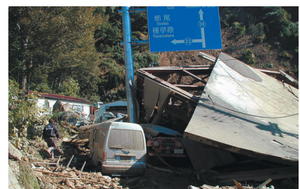
柏崎高浜堀之内線羽黒トンネル入口付近の大崩落
