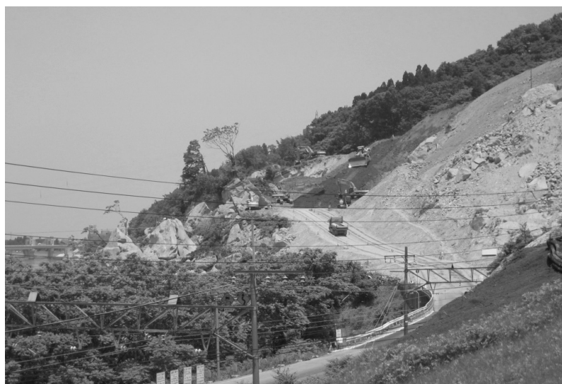
写真4 復旧が進む長岡市妙見町信濃川右岸斜面崩壊現場 (平成18年6月3日撮影)
