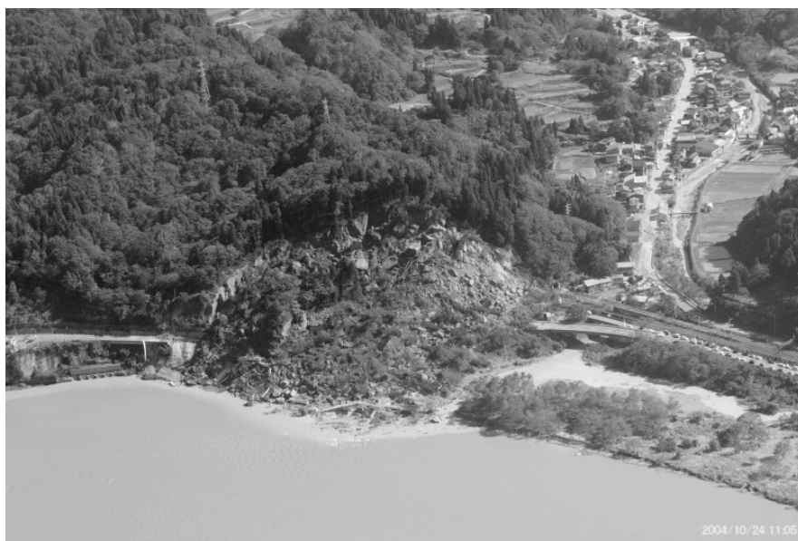
写真1 長岡市妙見町信濃川右岸斜面崩壊（平成16年10月24日撮影）
