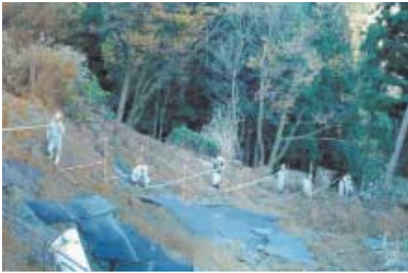
写真－2 道路崩落
